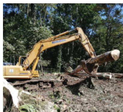
Las actividades de intervención donde se construirá la PTAR finalizaron el 11 de marzo.
